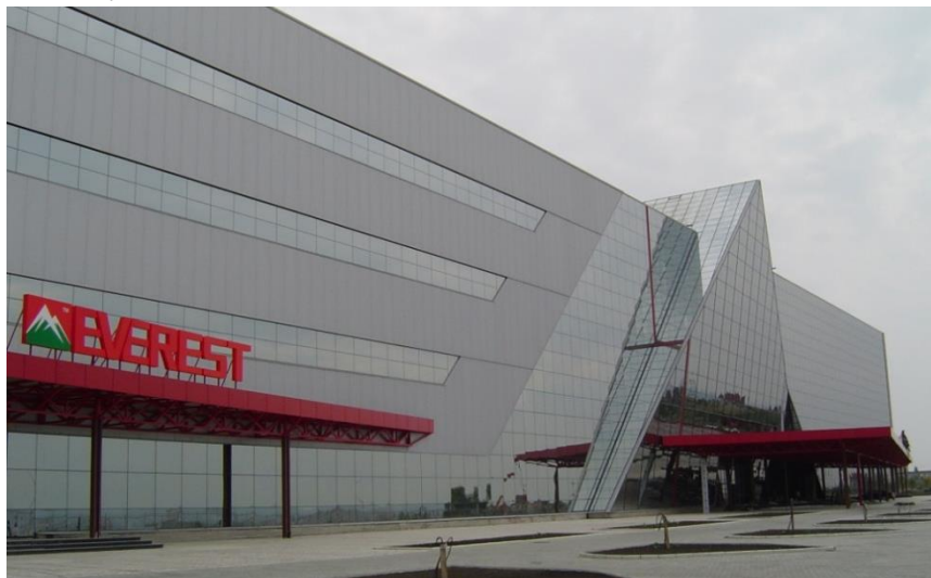
“三联”公司在摩尔多瓦投资的大型商贸综合中心
